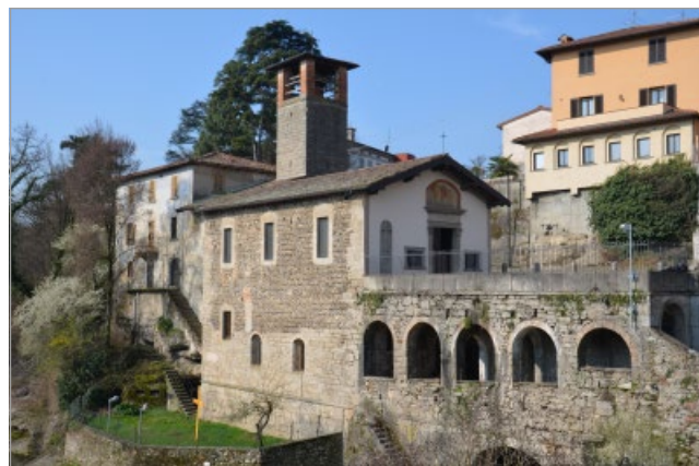
fig. 9 – Brembate, San Vittore. Facciata sul fiume.
