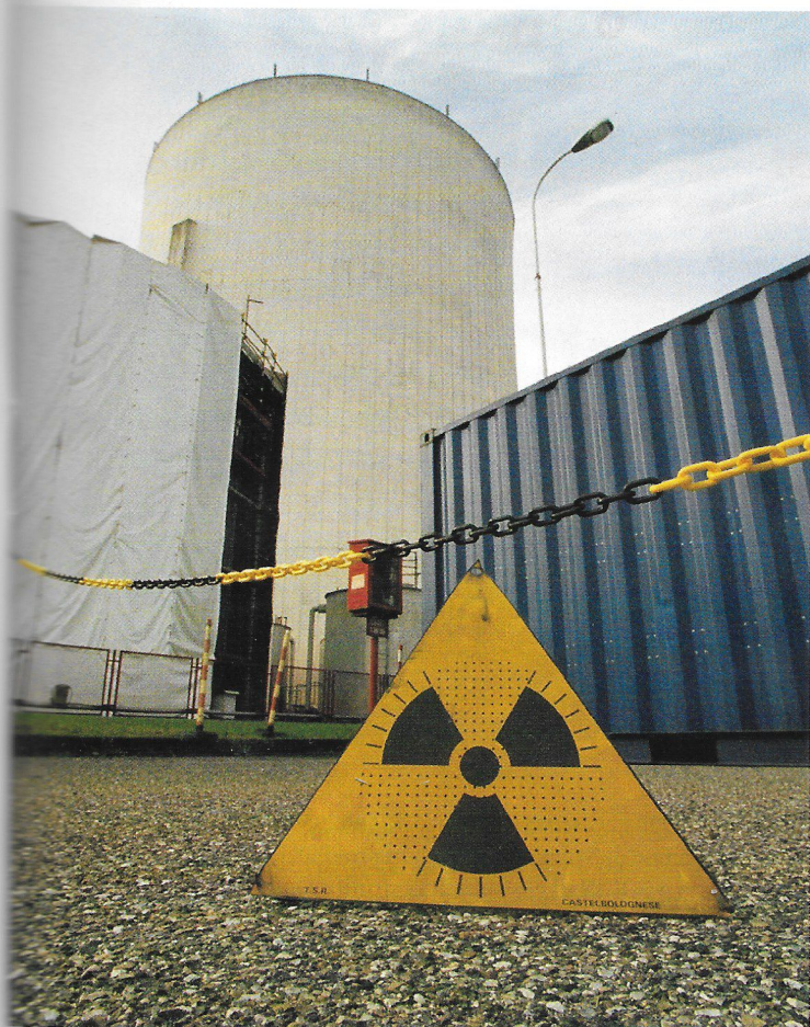
Contenimento cilindrico. La centrale di Caorso, di proprietà di SOGIN. Il cilindro bianco è la struttura di contenimento del reattore.
