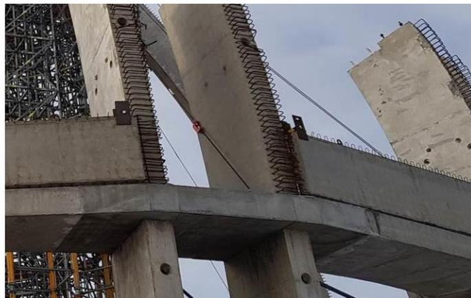
Fig. 17: particolare nodo di collegamento pannelli – archi/connection detail arches and panel.
