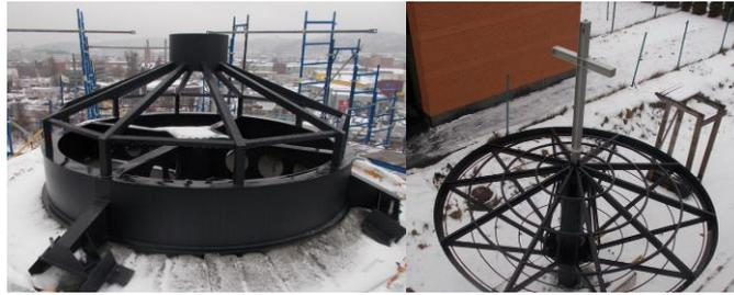
Fig. 19. Struttura sommitale a sostegno della croce/steel cross on top
