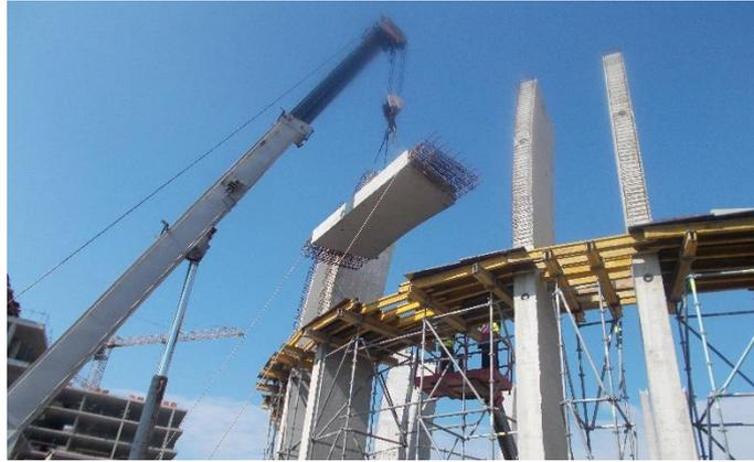
Fig. 14: varo travi anulari del primo livello/beam installations.
