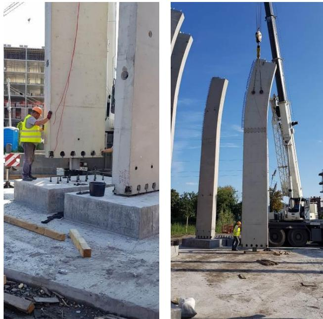
Fig. 13: posizionamento archi /arches installations.
