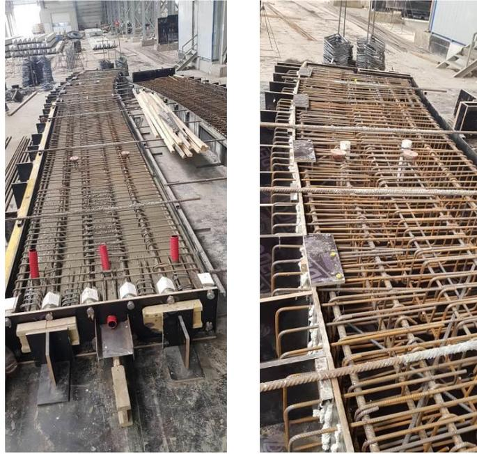
Fig. 11: fasi di prefabbricazione degli archi/
