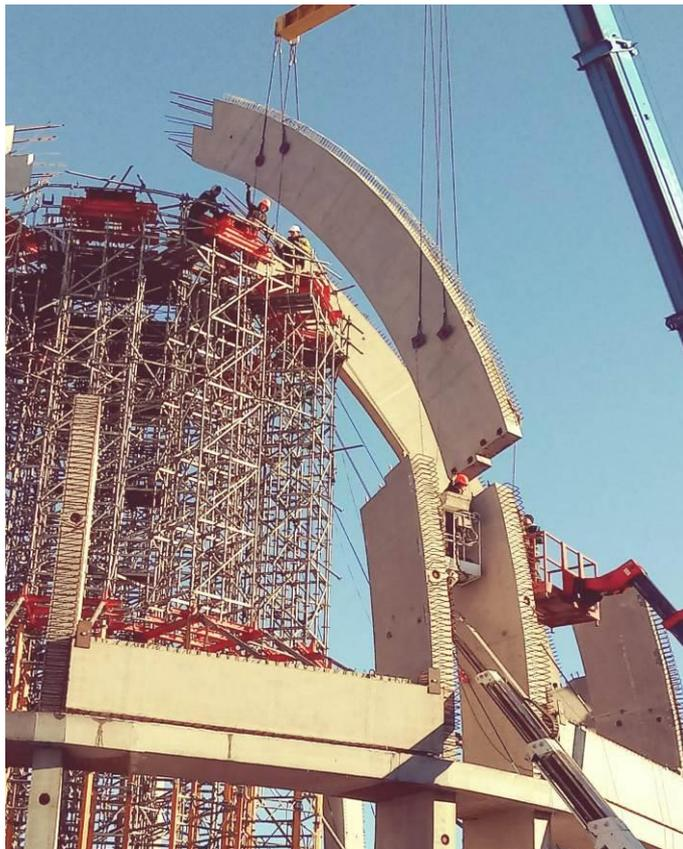
Fig. 15: montaggio archi secondo concio/ arches installations.
