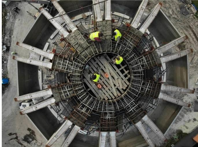
Fig. 16: fase di getto trave anulare del secondo livello/anular beam casting.
