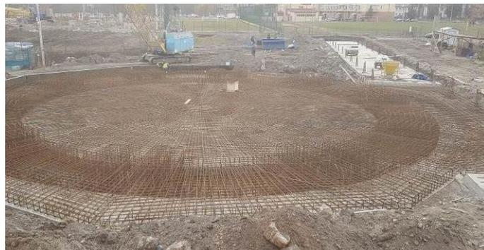
Fig. 9: armatura platea di fondazione aula liturgica/rebars foundation of the church.
